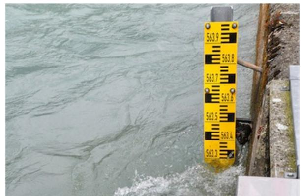
Bild 5: Mögliche Schwellenwertmarkierung
